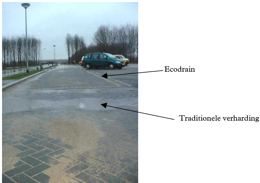
Figuur 1 Functioneren bij hevige regenval, let op nat voetpad aan linkerkant
