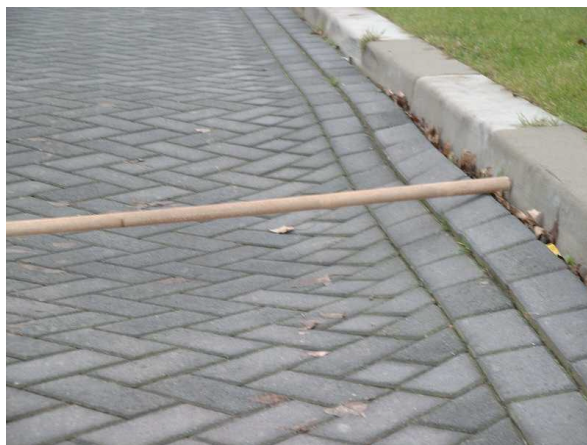
Figuur 6 Spoorvorming traditionele verharding vlak voor bocht
