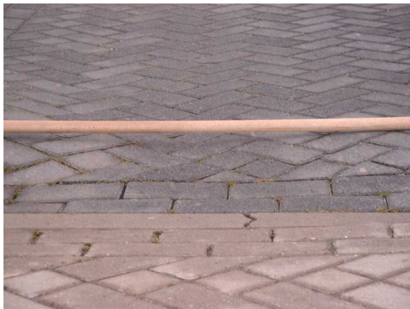
Figuur 5 Spoorvorming traditionele verharding rijweg
