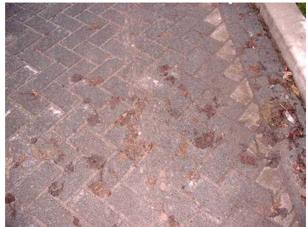
Figuur 3 Dichtslibbing Ecodrain
